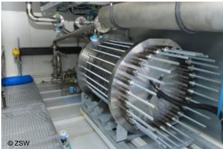
Bei der Elektrolyse wird Wasser durch den Einsatz elektrischer Energie in seine Bestandteile Sauerstoff und Wasserstoff zerlegt. Durch den starken Ausbau erneuerbarer Energie, insbesondere Photovoltaik und Windenergie, wird die Erzeugung von Wasserstoff mit grünem Strom zukünftig deutlich an Bedeutung gewinnen. Denn
